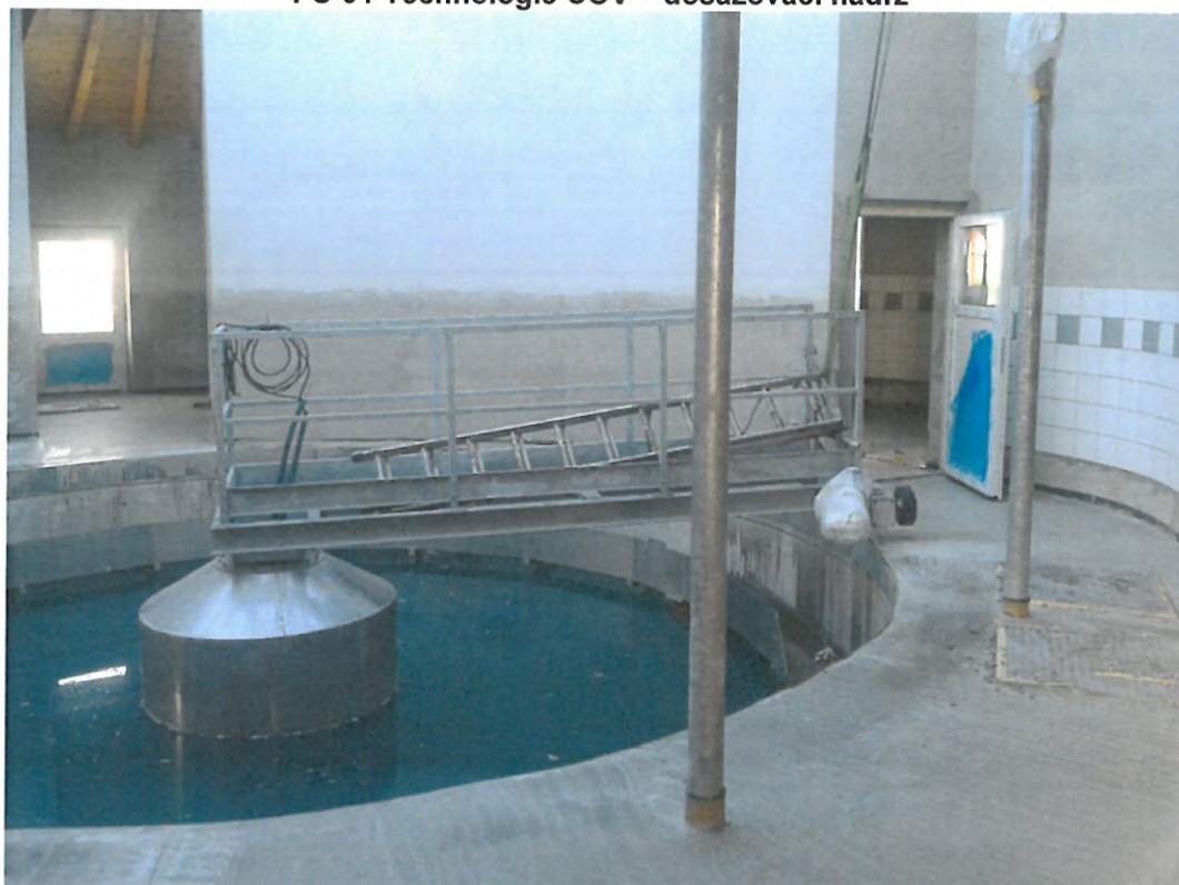
PS-01 Technologie ČOV – dosazovací nádrž
